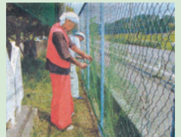
破れた金網を補修する 商工会建設業部会
